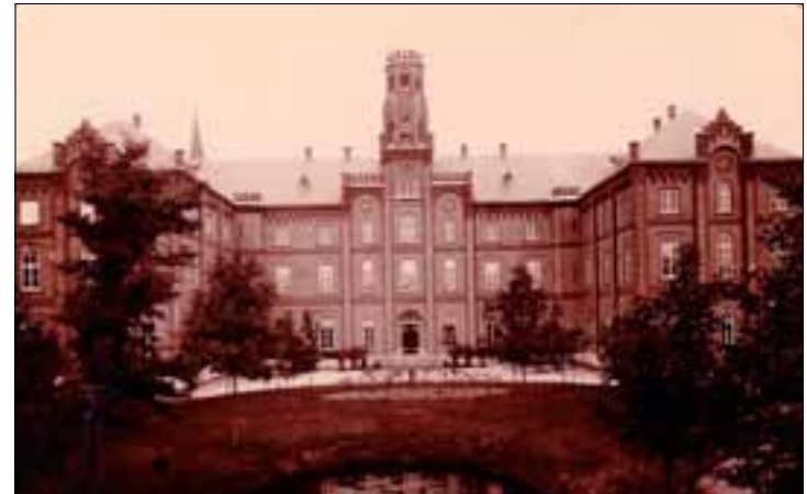
De voorgevel van het noviciaat in Velp. Foto: Archief Jezuïeten, Nijmegen
